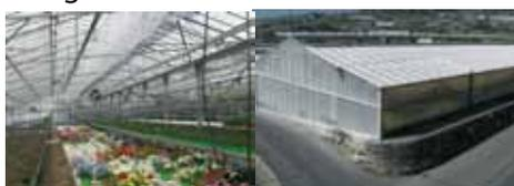
Fig. 2. A sinistra, serra tipica di Sanremo. Si noti la apertura delle finestrate sul colmo: l'eventuale brezza che scivola lungo le falde del tetto tende ad entrare e a fuoriuscire immediatamente dalla serra, attraverso la finestra opposta a quella di entrata. A destra: deflettore installato sul colmo di una serra dell'azienda Solaro per aumentare l'efficienza della ventilazione della serra.
